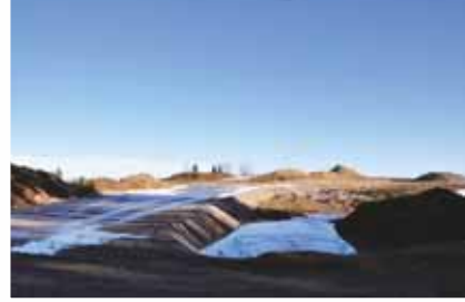
Baustelle Geothermie Icking; Fotos: F. Krönauer
